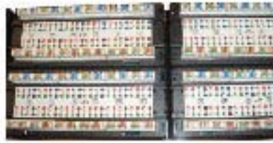
Επαφές IDC τυπωμένου κυκλώματος με χρωματικό κώδικα.
